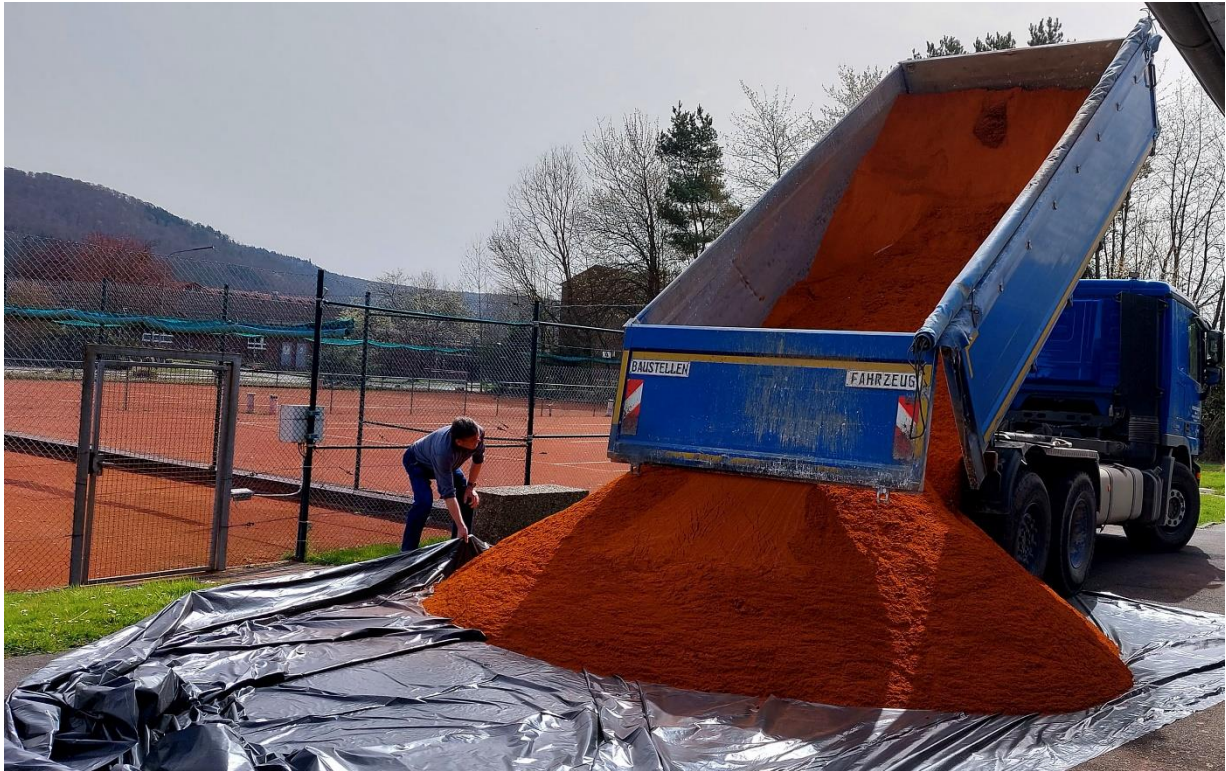
Am 13. April wurden 11 Tonnen Sand angeliefert
