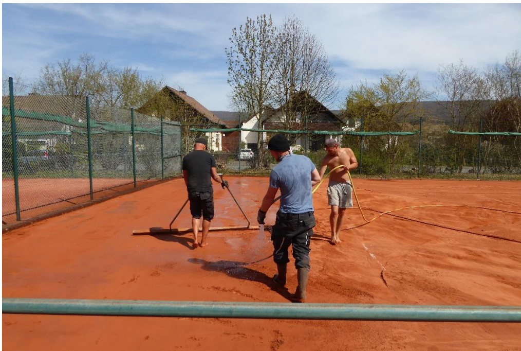
Der neue Sand wurde am 15.04.20 mit viel Wasser auf Platz 4 eingeschlämmt
